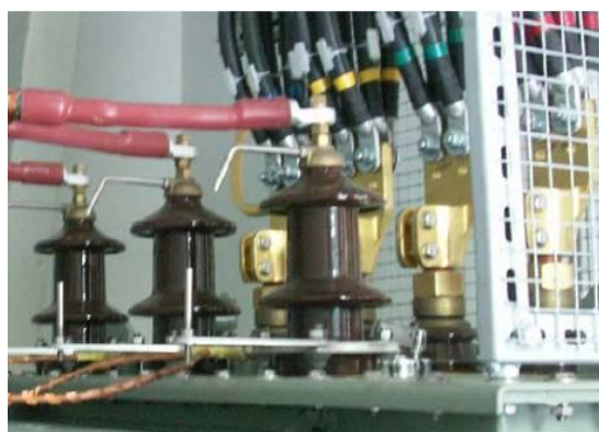
Рис. 15. Электросетевое хозяйство. Трансформаторная подстанция. Идентификация перегретых контактов
