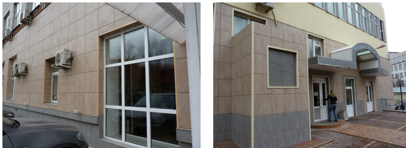
Внешний вид штыревого навесного вентилируемого фасада
