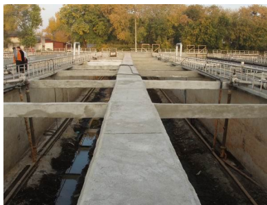
Рис. 7. Очистные сооружения. г.Магнитогорк, левый берег (после ремонта материалами ЭМАКО)
