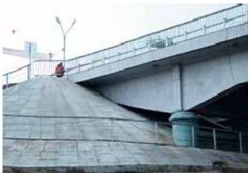
Рис. 2. Автомобильный мост через р.Протва после ремонта материалами серии ЭМАКО
