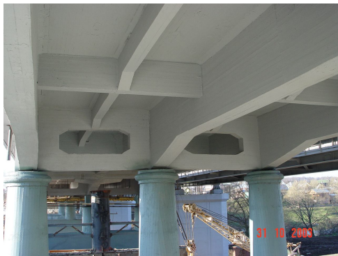
Рис. 9. Мост через р.Протва. Вид после ремонта материалами ЭМАКО и нанесения МАСТЕРСИЛ 540
