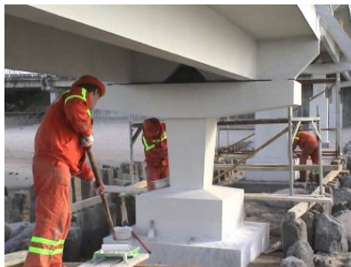
Рис. 4. Он же (после ремонта материалами ЭМАКО и защиты материалом МАСТЕРСИЛ 540)
