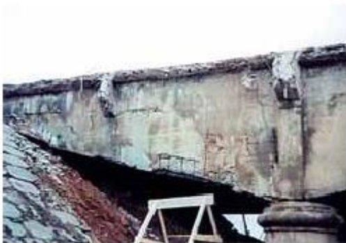
Рис. 1. Фрагмент автомобильного моста через р.Протва (состояние до ремонта)
