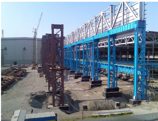
Рис. 7. Площадка строительства здания машины непрерывного литья заготовок ОАО «ММК»
