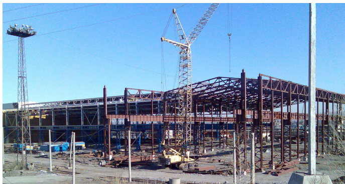
Рис. 8. Площадка строительства ЛПЦ-11 ОАО «ММК»
