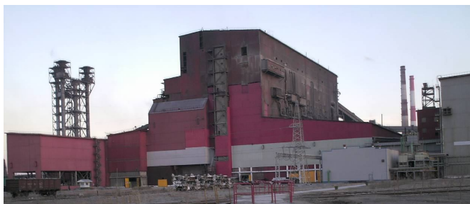
Рис. 1. Здание кислородно-конверторного цеха ОАО «ММК»
