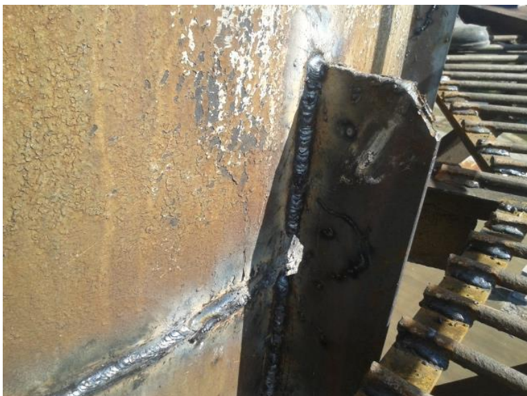
Рис. 4. Отремонтированный участок ствола металлической дымовой трубы
