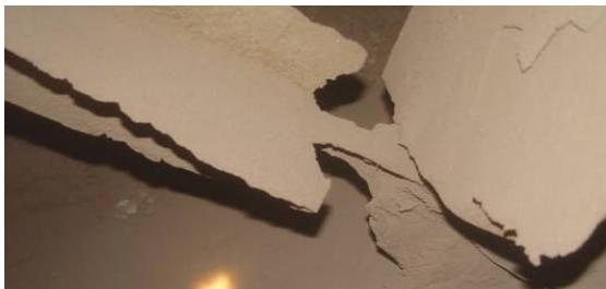
Рис.8. Фрагмент каркаса, скопление пыли и коррозия в узле
