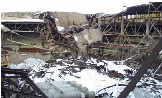
Рис.4. Аварийное разрушение диска покрытия здания термокалибровочного цеха ОАО «Златоустовский металлургический завод», февраль 2001 г.
