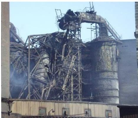
Рис.3. Аварийное обрушение вытяжной башни №175 высотой 100 м сероулавливающей установки аглоцеха горно-обогатительного производства ОАО «Магнитогорский металлургический комбинат», апрель 2002 г.
