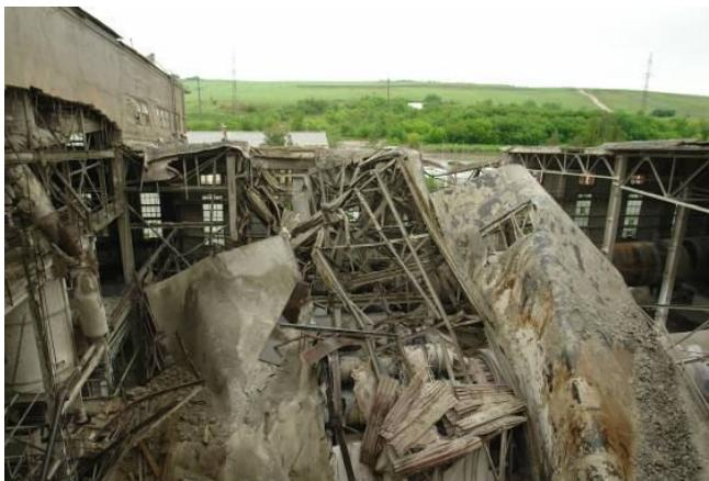
Рис.2. Аварийное разрушение блока покрытия здания вращающихся печей ОАО «Магнитогорский цементный завод», сентябрь 2006 г.
