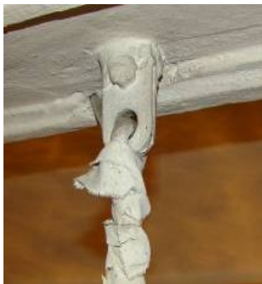
Рис. 13. Узел крепления люстры бокового зала второго яруса
