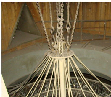
Рис. 3. Узел крепления люстры зрительного зала
