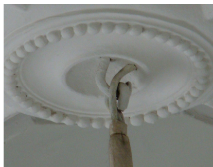
Рис. 11. Узел крепления люстры перехода
