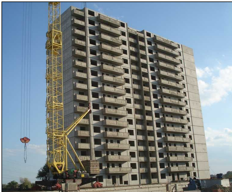
Рис.1. Общий вид здания в период испытаний
