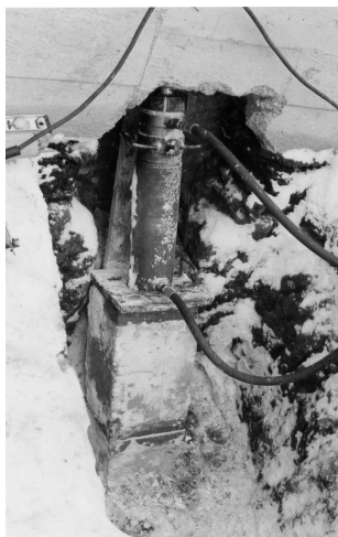
Рис. 6. Вдавливание многосекционных свай домкратом
