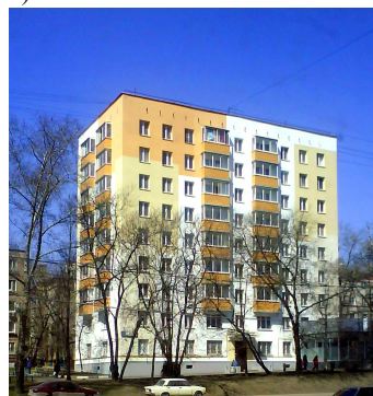
Рис. 6. Жилые полносборные дома с наружными стенами из крупных блоков по Ярославскому шоссе в г. Москве: а – до усиления теплозащиты; б – после усиления теплозащиты
