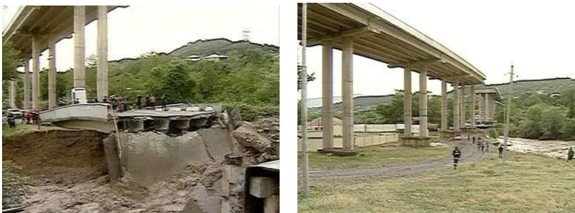
Рис. 19. Обрушение автомобильного моста через реку Глданула, г.Тбилиси
