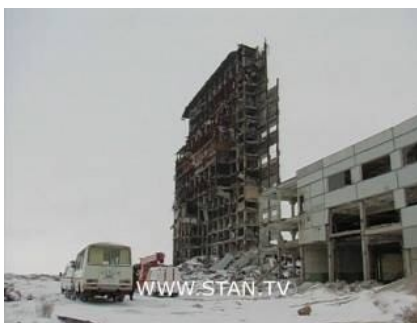
Рис. 14. Обрушение конструкций здания на радиолокационной станции "Дарьял-У"
