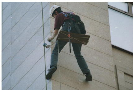
Фото 3. Установка деформационных марок на здание альпинистом
