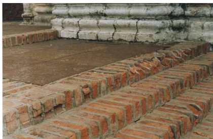
Рис. 1. Фрагмент кладки ступеней одного из храмов в Ростове Великом. Реконструкция проводилась 5 лет назад
