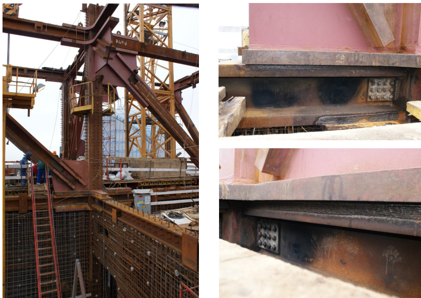
Рис. 5. Аутригерная ферма на 47-м этаже. Сварные соединения горизонтальных элементов фермы
