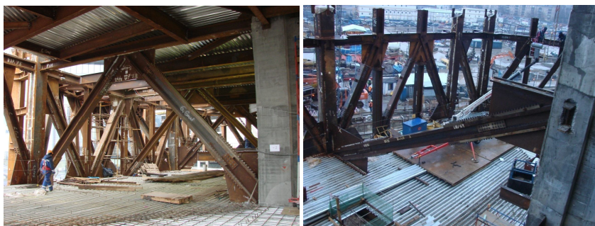
Рис. 3. Аутригерная ферма на 2-м этаже
