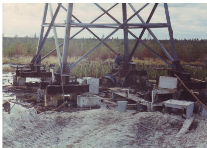
Рис. 2. Рабочий момент усиления свайных фундаментов опор ЛЭП
