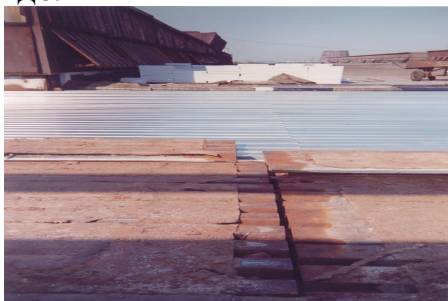
Рис.3. Укладка настила без нахлестки
