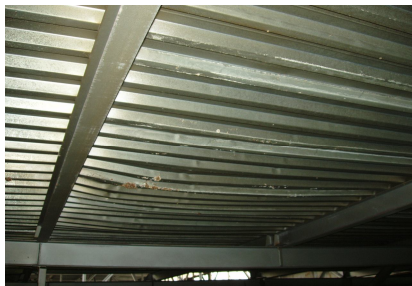
Рис. 2. Деформированный участок профилированного настила
