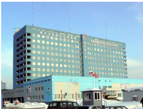
Рис. 1. Общий вид здания кардиологического центра в г. Кемерово
