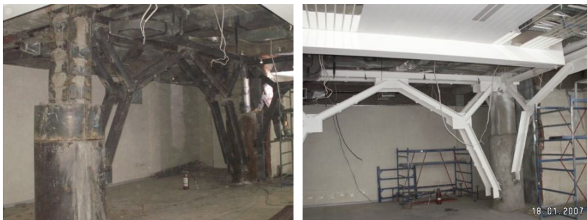
Рис. 7. Установка дополнительных порталных связей между усиленными колоннами первого этажа
