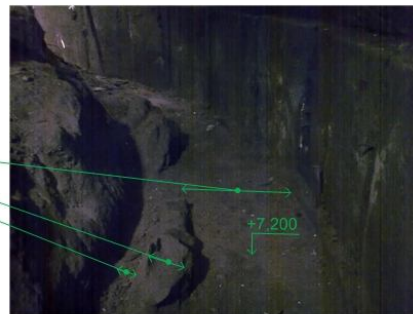
Рис. 7. Демонтаж обстановочных блоков горна
