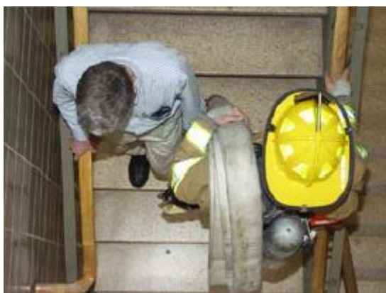
Рис. 5. Уменьшение фактической ширины пути эвакуации на лестничных клетках башен Всемирного торгового за счет встречного движения двух потоков людей: эвакуирующихся вниз, и пожарных,двигающихся вверх, в зону ЧС
