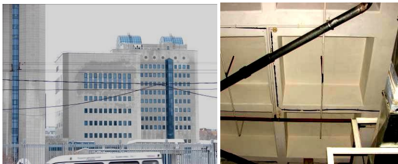
Рис. 10. Общий вид обследуемого здания и вид ребер перекрытия
