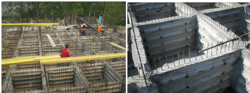
Рис. 2. Общий вид перекрытия и ячейки перекрёстных ребер
